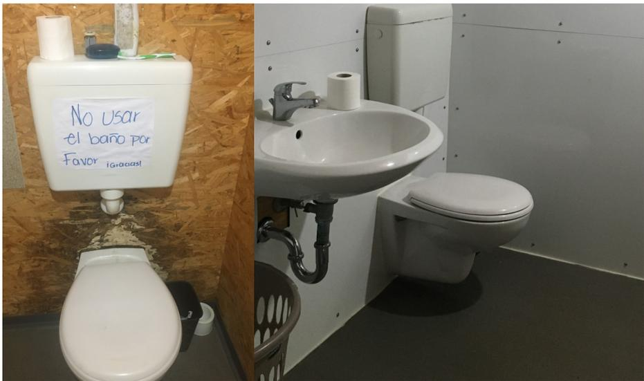
Im zweiten Stock wurden alle 12 Badezimmer saniert. An den Wänden wurden abwaschbare Platten aus Aluminium verlegt. Das soll verhindern, dass sich im Holz durch das Eindringen von Wasser Fäulnis entwickelt.
